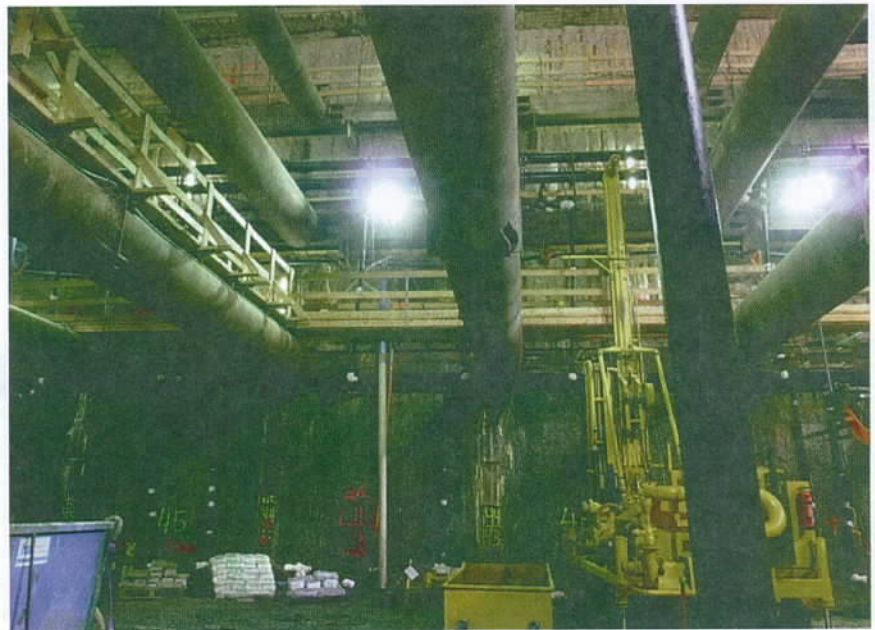
Abb. 5 Bohrarbeiten in der Station Vijzelgracht
