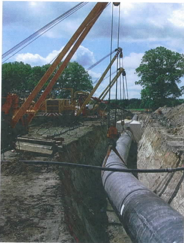
Abb. 3 Beidseitig des Rohrgrabens eingespülte Filter
