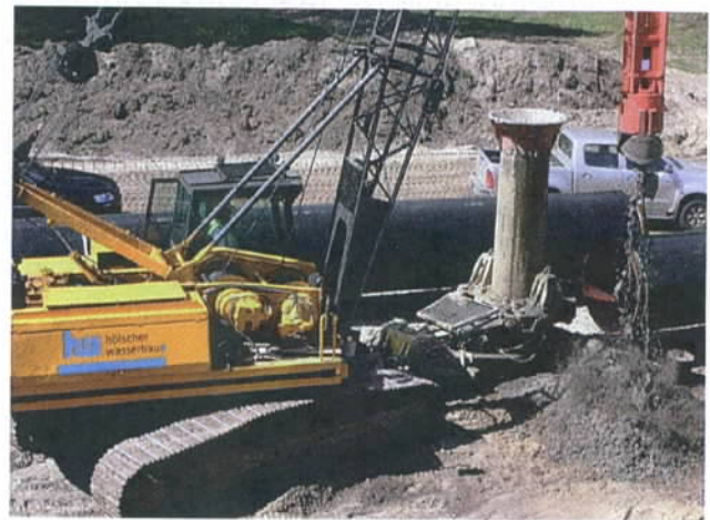
Abb. 4 Bohrgerät im Einsatz
