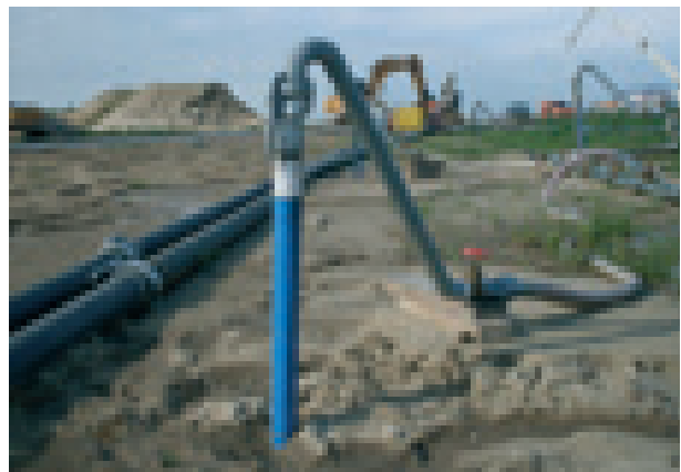
DSI in Spüllanzen. Q = 15 \text{ m}^3/\text{h} je 2" Lanze.
