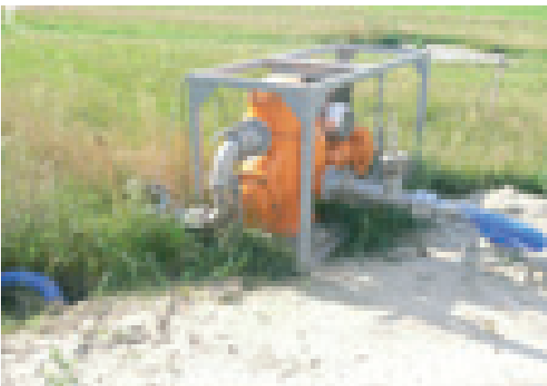
DSI im Hori-Drain direkt unter Absenkdrain. Q = 18 \text{ m}^3/\text{h} je Strang.
