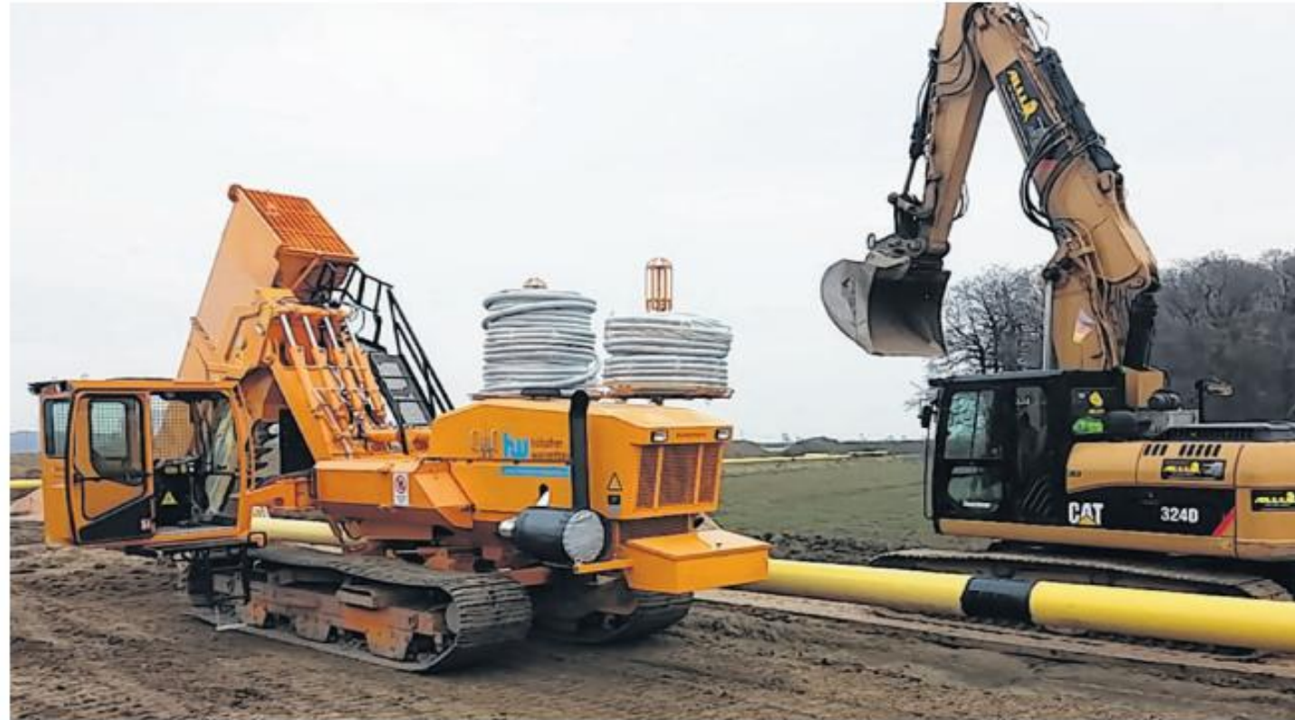
Hat kein Problem mit sandigem und weichem Untergrund: die neue Fräse Gigant 3600.
